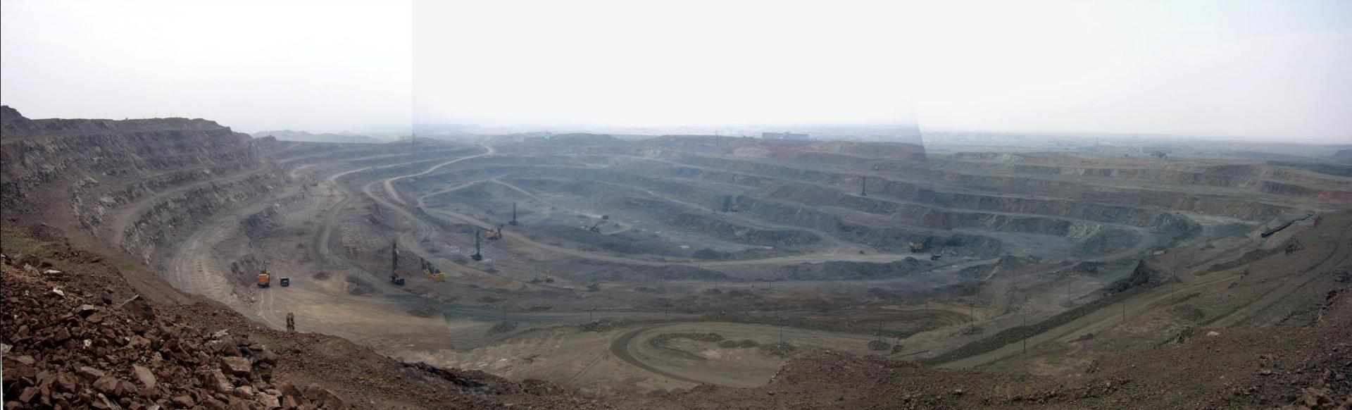
図1(a) 中国・内モンゴル自治区のバイヤンオボ鉱床. 中国の内蒙古自治区に位置するバイヤンオボ鉱床の露天採掘場。バイヤンオボ鉱床は、主に鉄を採掘している鉱床であり、レアアースは副産物として生産されている。この鉱床は、La, Ce, Ndなどの軽希土に富む鉱床である。レアアース生産量及び埋蔵鉱量ともに世界最大で、現在もこの鉱床が世界のレアアース生産を牽引している。（産業総合技術研究所 村上浩康主任研究員撮影・提供, 2005年8月撮影）
